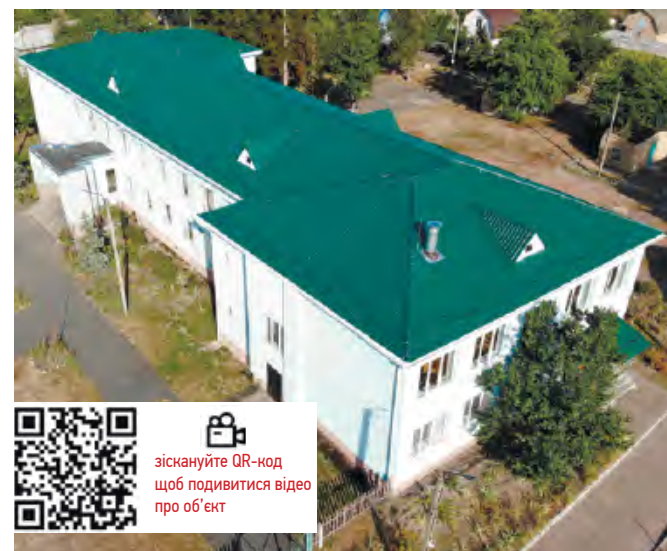
Металочерепиця «Арсенал» (будівля школи)
