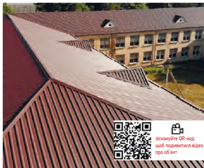
Профнастил покрівельний (будинок школи)
